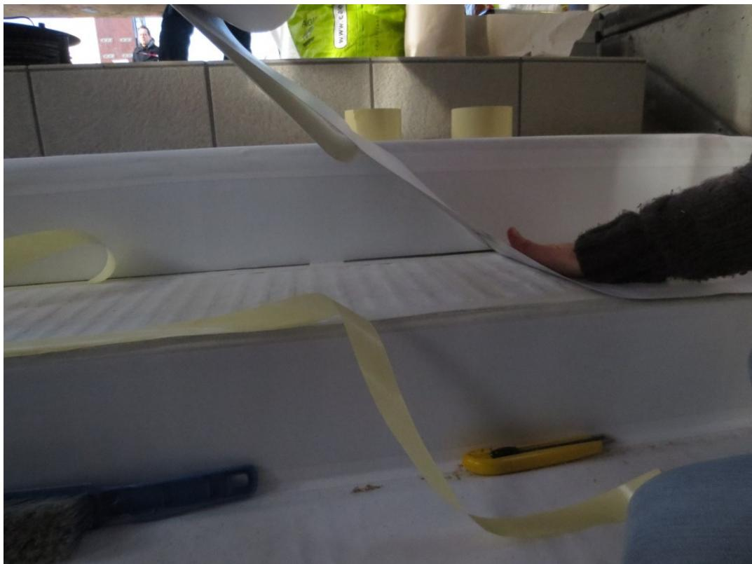
Avec les stickers de contre marche et les bandes de joints on obtient un composé qui semble se mouler à l'escalier et être à l'épreuve du climat breton.
